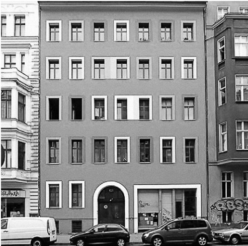
Abb. 3: Fassade der Zossener Straße 5
