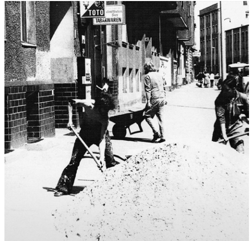
Abb. 4: Bauarbeiten Zossener Straße 5 (1978)
