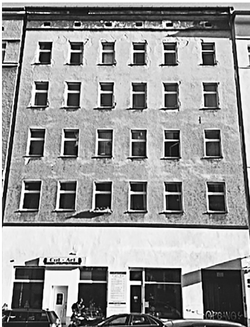
Abb. 6: Fassade Zossener Straße 48
